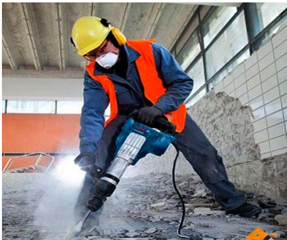
Рис. 19. Работа с отбойным молотком
