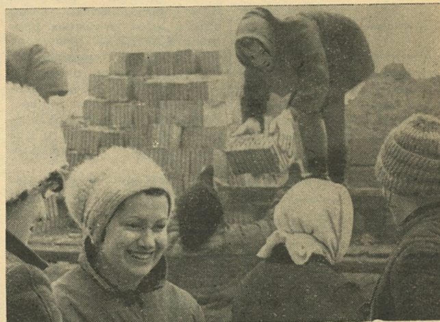
Студенческий субботник. Возводится новый корпус института.
