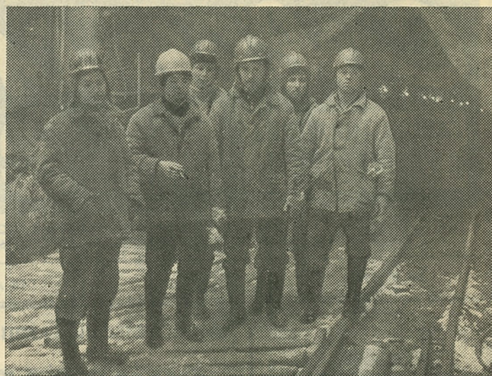
Коммунистический отряд студентов нашего института в дни зимних каникул ударно трудился на строительстве Минского метрополитена.
