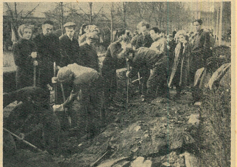
НА СНИМКЕ: комсомольцы первого курса (3-й поток) роют траншею для газопровода в районе стадиона «Динамо».
