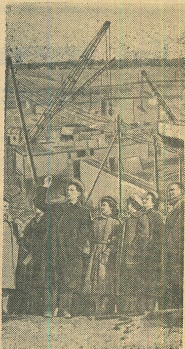
НА СНИМКЕ: делегаты конференции знакомятся со строительством Каунасской ГЭС.
