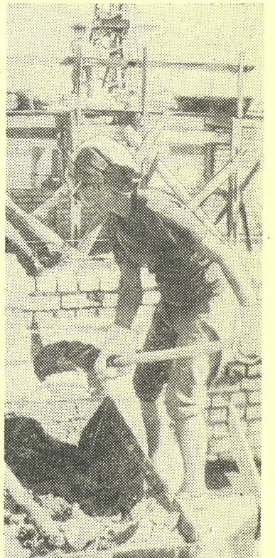
На снимке: Штукатур Тоня Антонова за работой.
