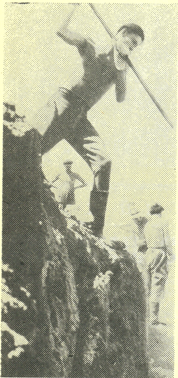
На снимке: Евгений Рыков на рытье котлована под фундамент здания школы.
