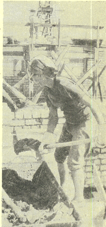
На снимке: Штукатур Тоня Антонова за работой.
