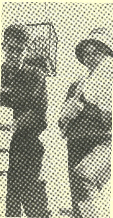
На снимке: Каменщик Евгений Рыков и его подсобник Валентин Бухаревич сегодня перевыполнили сменное задание по кирпичной кладке стен.
