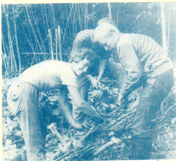
Вот так работали стройотрядовцы «Бригантины». На снимке: Л. Галицына и
