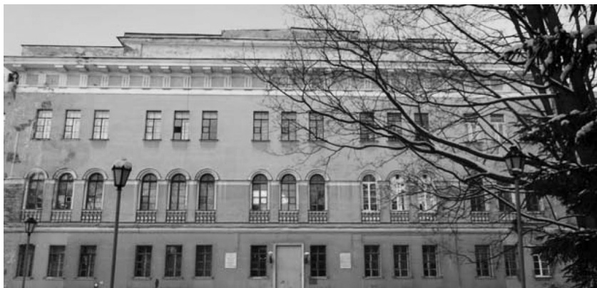
Вид на главный корпус госпиталя на Суворовском просп. г. С.-Петербурга
